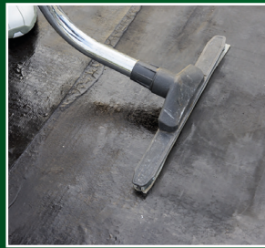
3 Oppervlak goed drogen met waterstofzuiger
