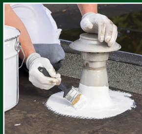
7 Behandel de dakrand en naden voor met Silicone Roofing TG
