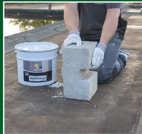
5 De gerenoveerde plek onder druk laten drogen
