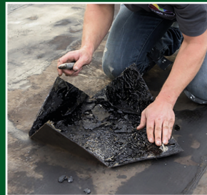
4 Kruislings opensnijden en binnenzijde insmeren met Silicone Roofing TG
