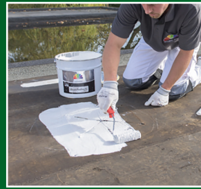
6 De reparatie plek behandelen met een extra laag Silicone Roofing TG
