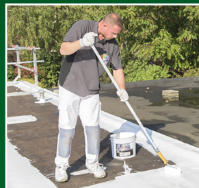
9 Het geheel afwerken met Silicone Roofing TG
