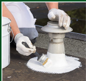
8 Doorvoeren en afvoeren behandelen met Silicone Roofing TG versterkt met vlies
