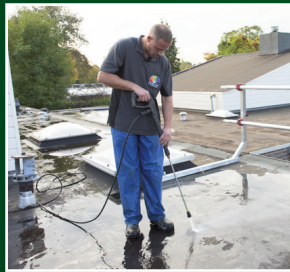
2 Reinigen met hogedrukreiniger
